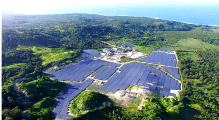
Gambar 16. PLTS Likupang 15 MW Minahasa Utara, Provinsi Sulawesi Utara
